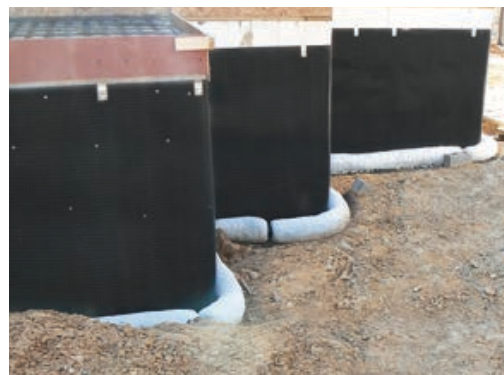
Защита гидроизоляции и дренаж
