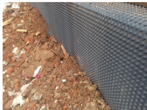
Защита гидроизоляции
